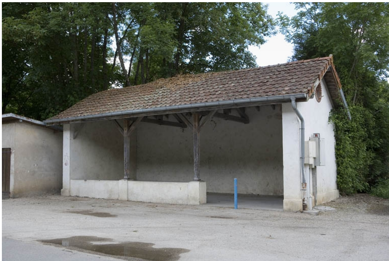
Cité ouvrière. Lavoir.
