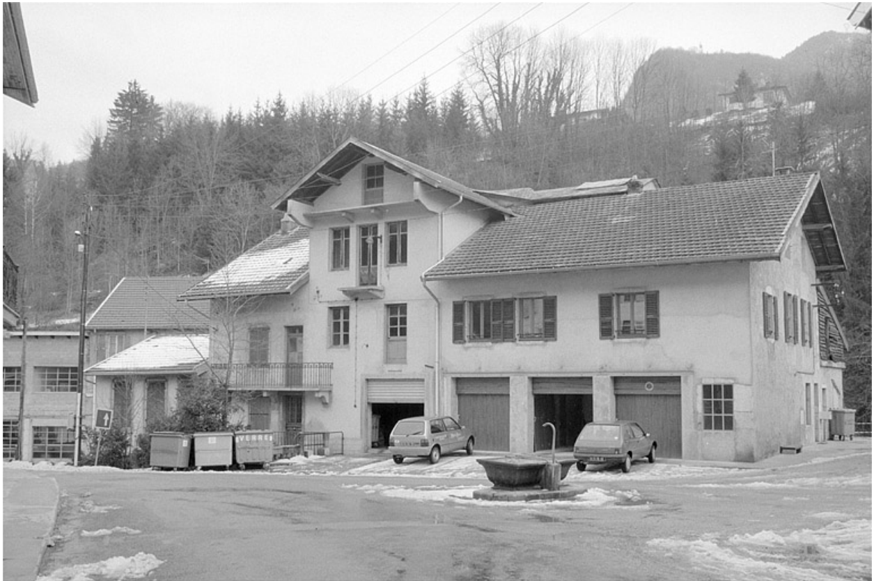
Minoterie et logements.
