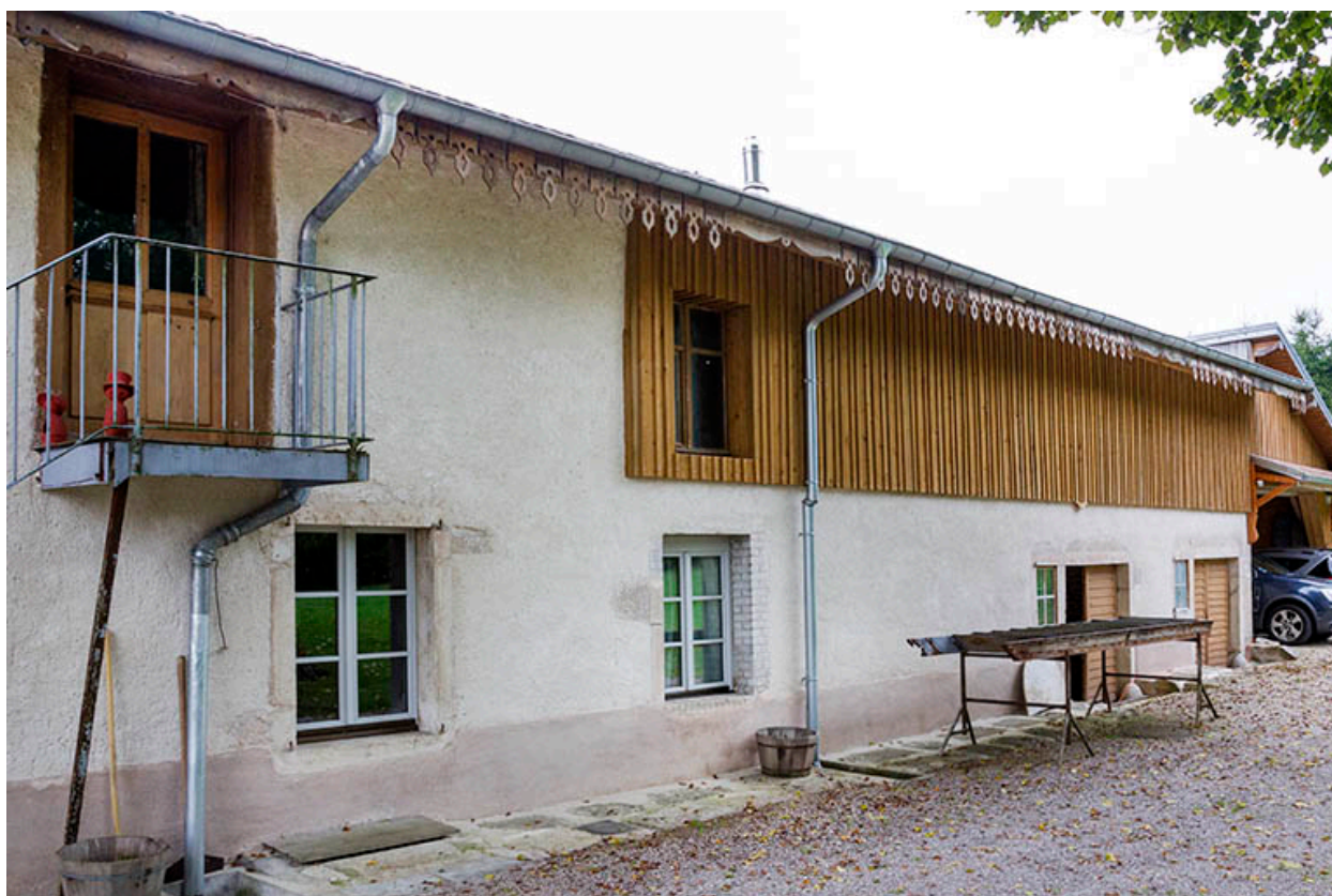
Façade latérale droite.
