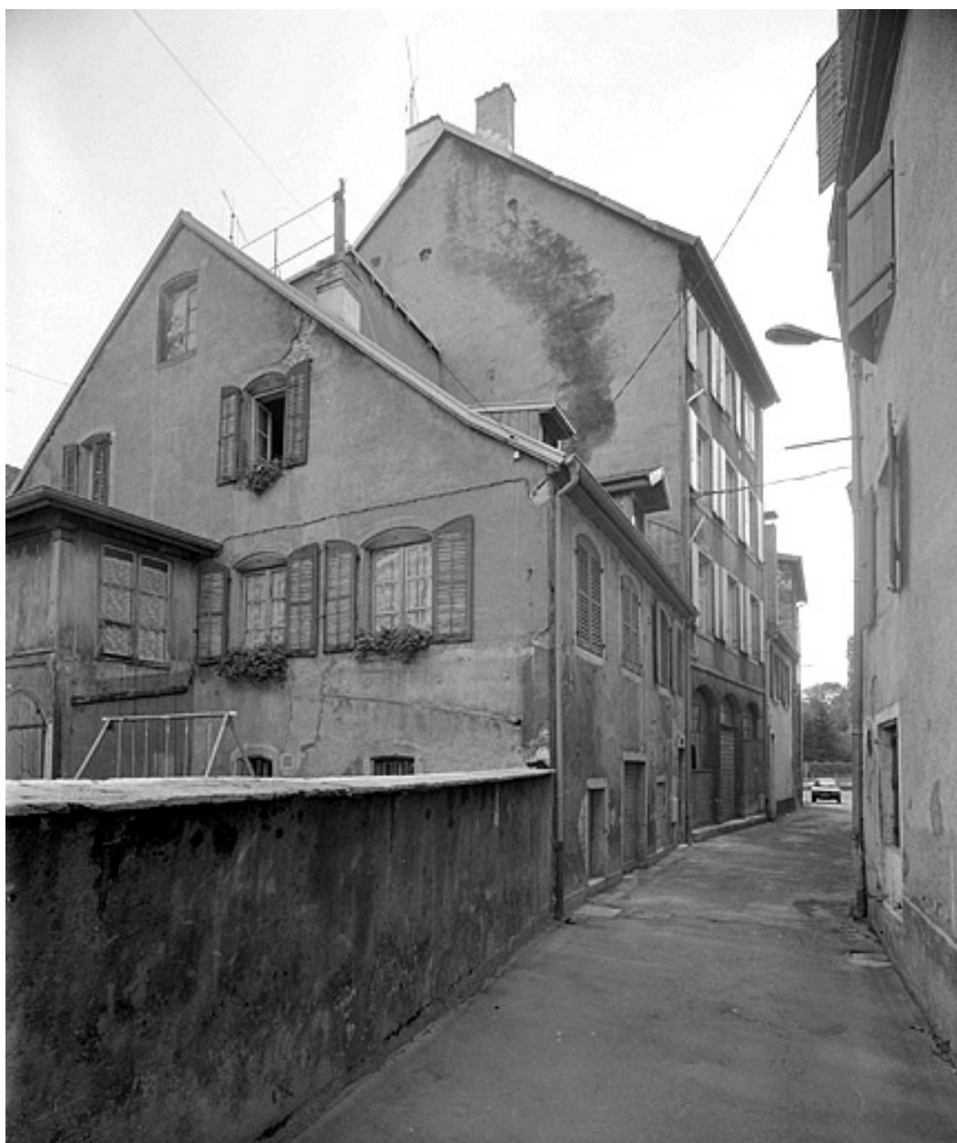
Façade sur la rue des Tanneries.
