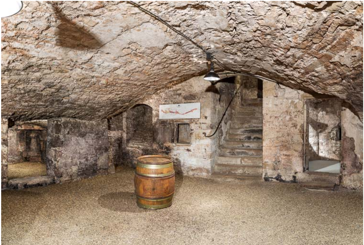
Casemate inférieure de la tour sud-ouest.
