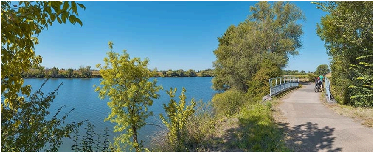
Le pont sur la Vandaine.
