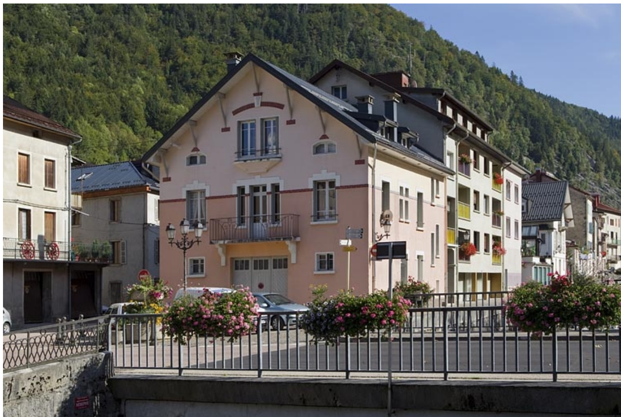
Vue d'ensemble, depuis l'ouest (cadrage horizontal).
