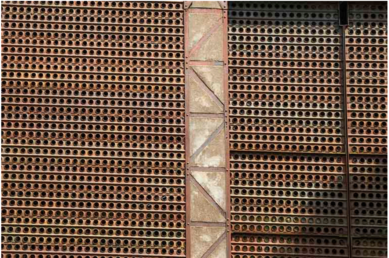
Site rue du Jura : paroi de l'entrepôt industriel (plaques de désensablement).
