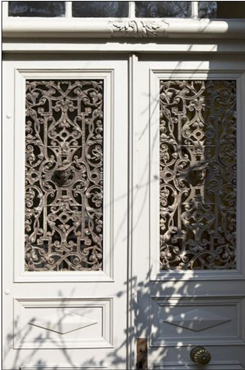
Détail du décor en fonte des deux panneaux de la porte d'entrée.
