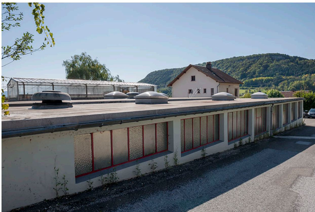
Façade sur rue de l'atelier de fabrication.
