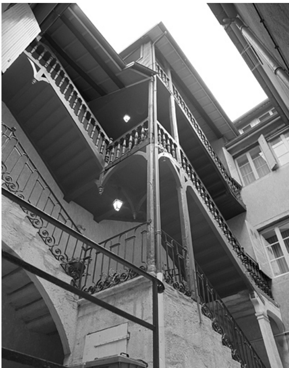
Escalier dans la cour.
