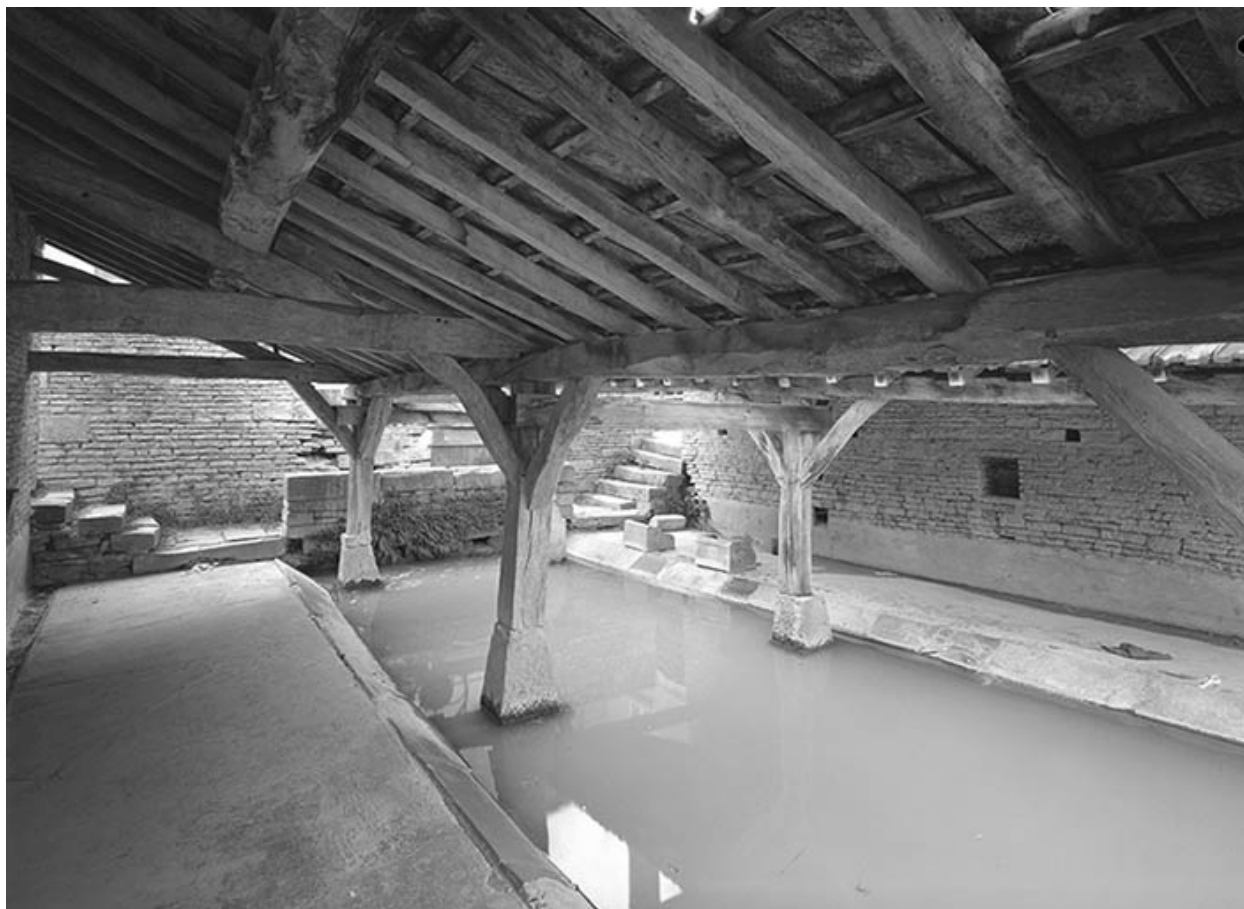
Vue intérieure. Bassin et charpente.
