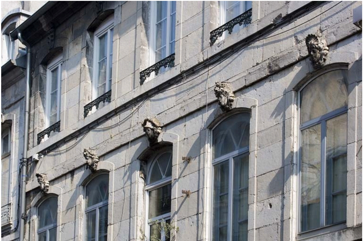
Détail des fenêtres au premier étage sur rue.
