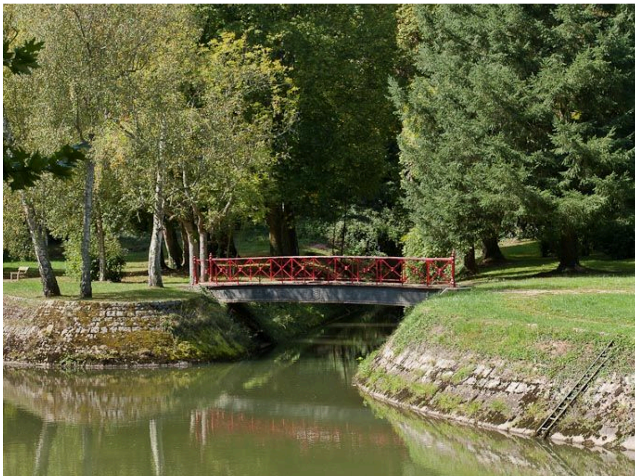
Vue d'un pont sur rigole.
