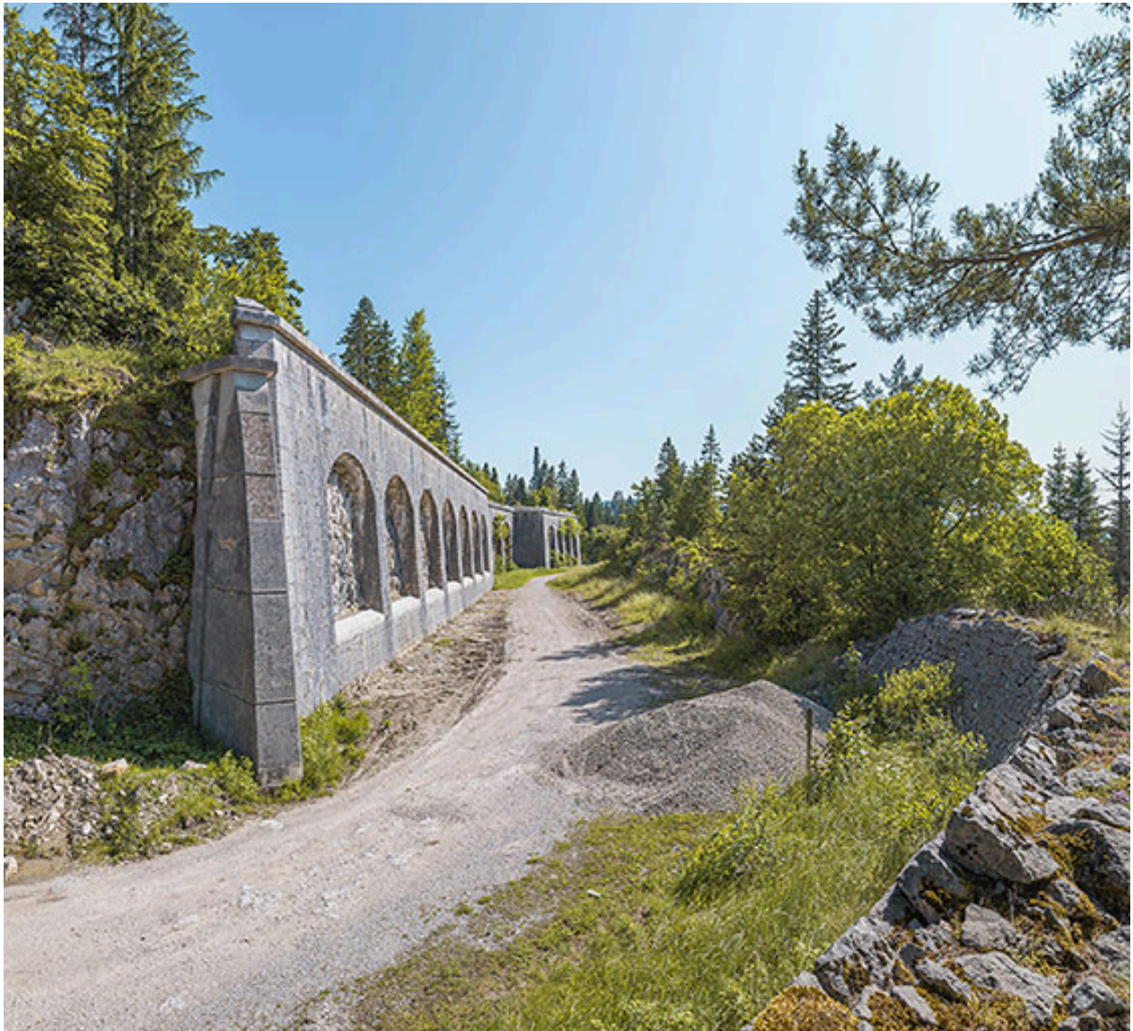
Front ouest : vue en enfilade des arcs de décharge du rempart.
