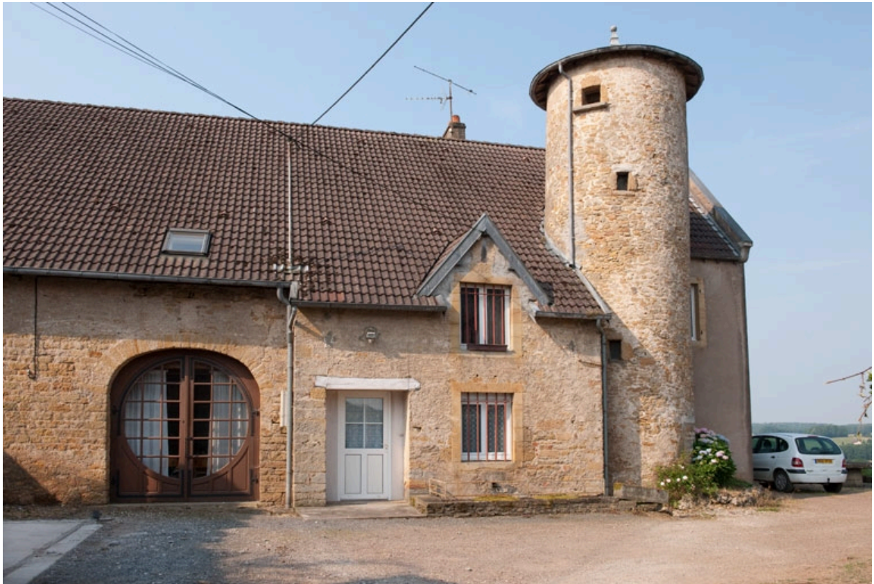
Façade antérieure, vue de trois quart gauche.
