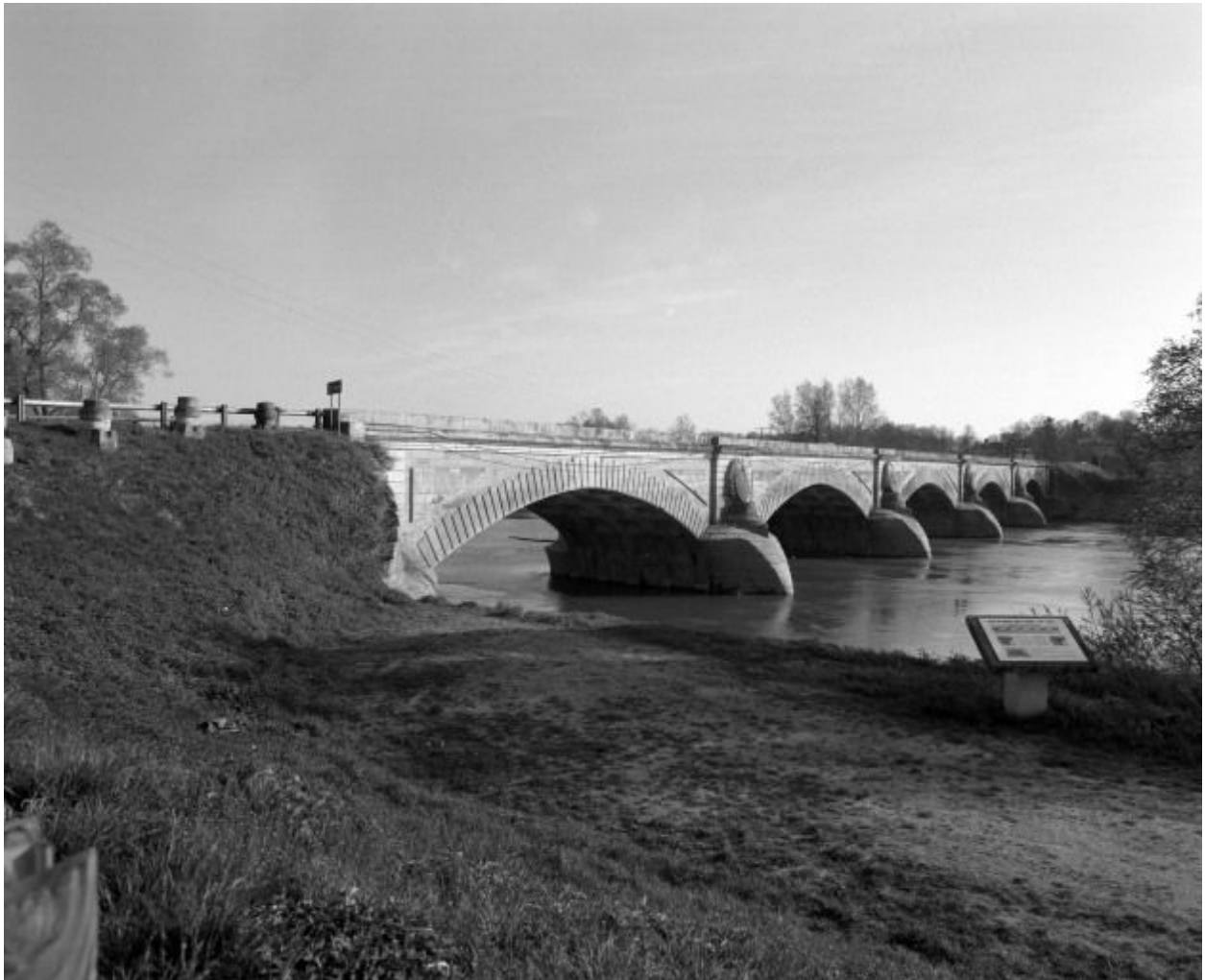
Vue d'ensemble de trois-quarts gauche, en aval.
