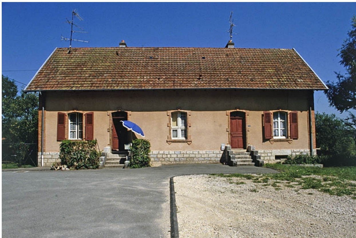
Façade antérieure d'un logement à 2 appartements.
