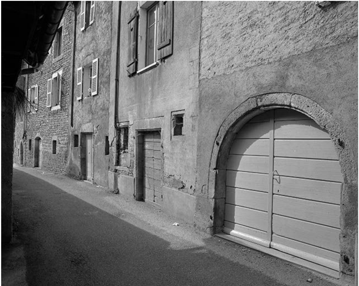
Vue du revers des maisons, côté pair de la rue des Martinets, de droite à gauche 16 à 12.
