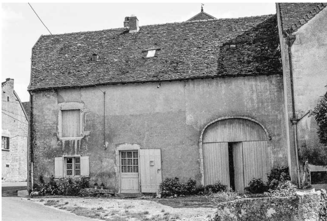
Ferme cadastrée AD 329 : façade antérieure.
