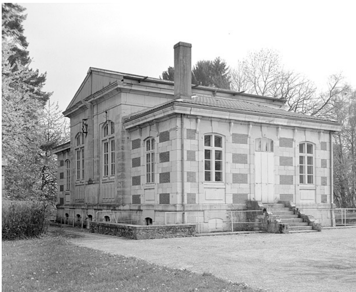
Façades nord et ouest.
