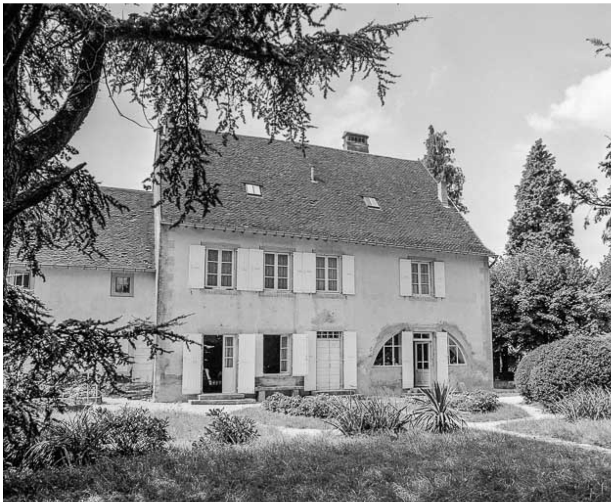
Ferme n° 16 : façade postérieure, partie gauche.
