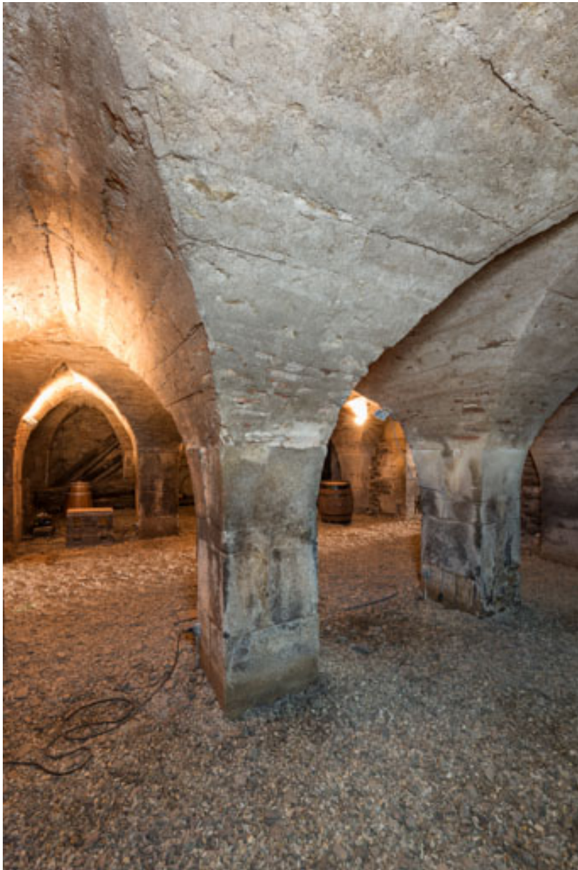
Pavillon occidental : cave à l'étage de soubassement.
