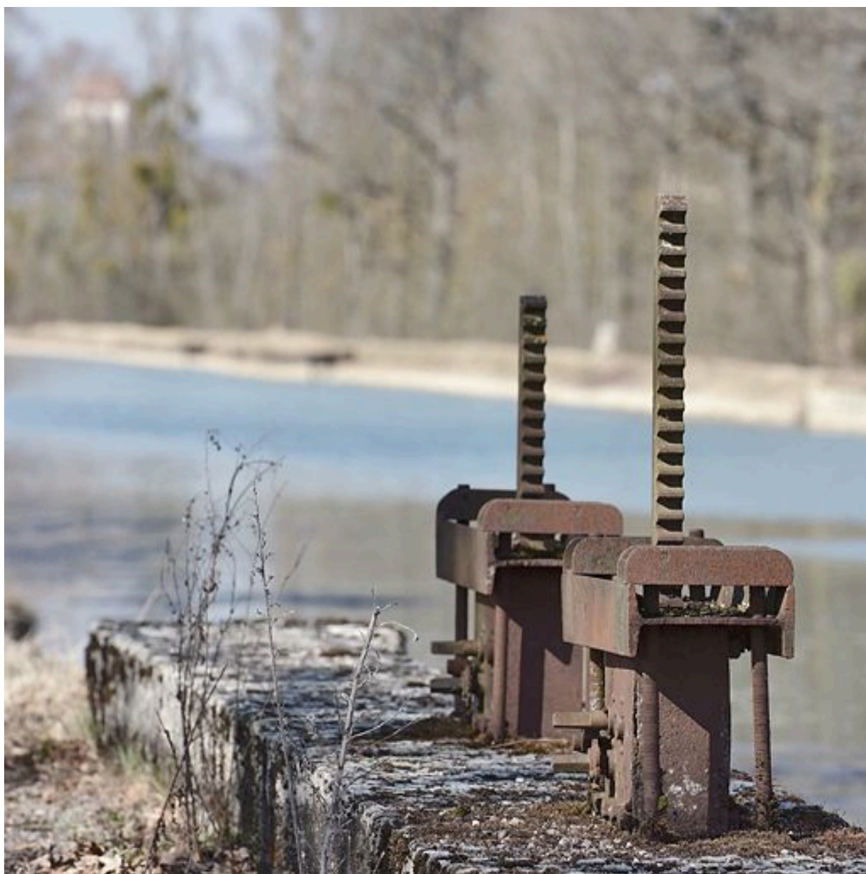
Sortie de l'aqueduc de Beuriset : détail des deux vannes.
