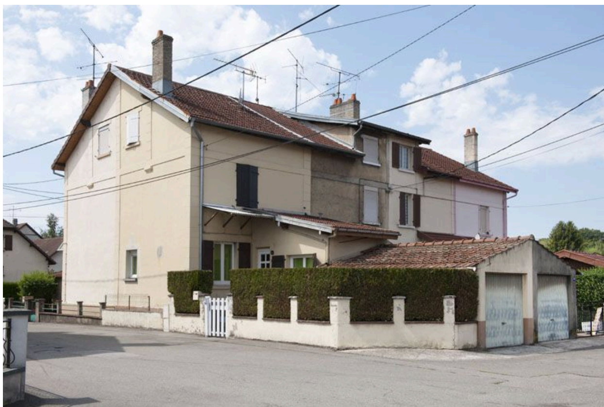
Habitation à 8 logements vue de trois quarts.
