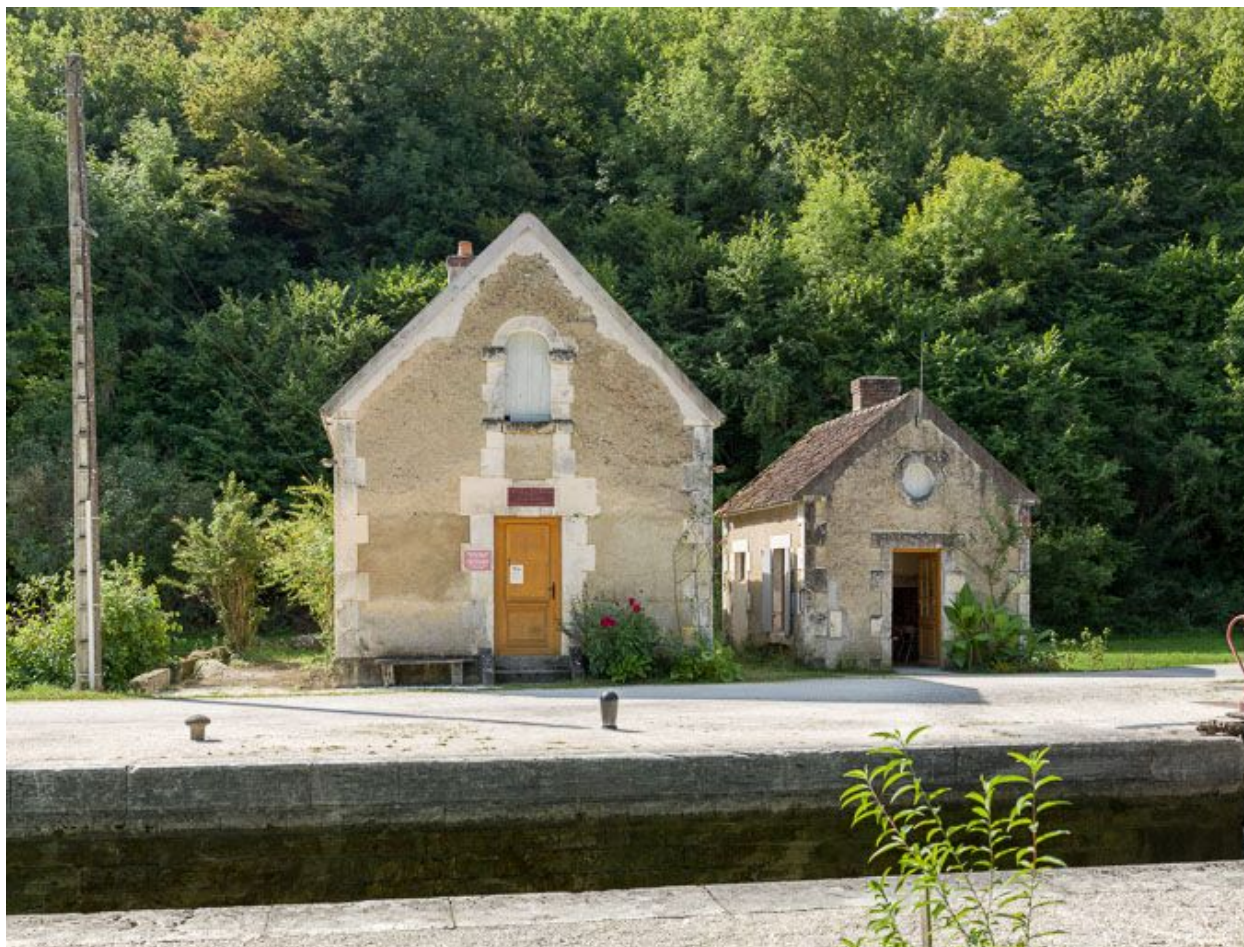
Vue de la maison éclusière de face.
