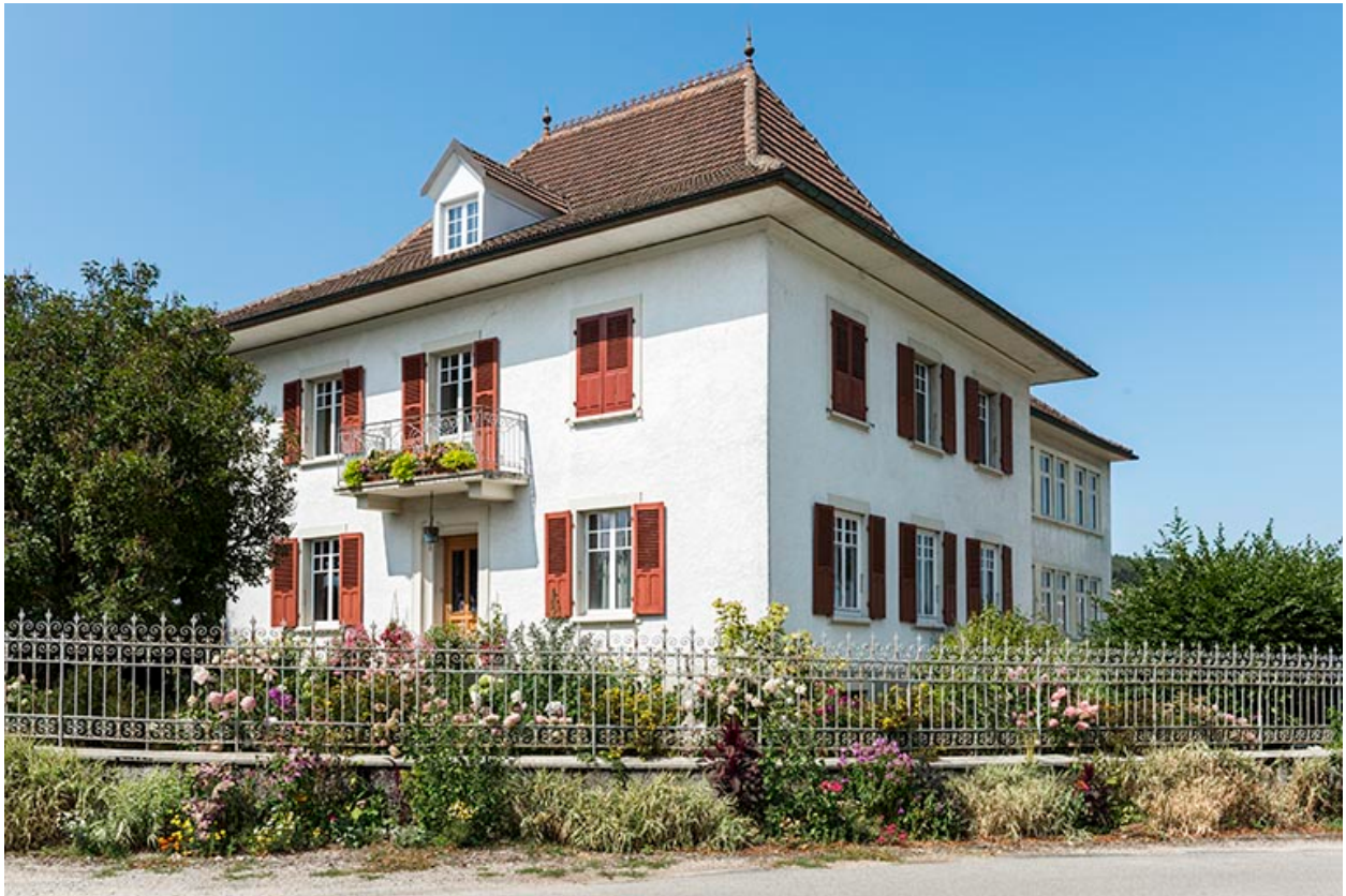
Maison : façades antérieure et latérale droite.
