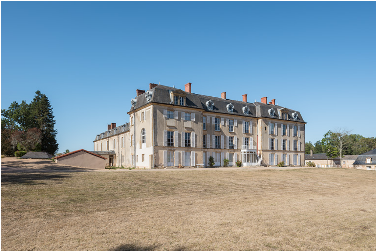
Façade sur le parc, vue de trois quarts.
