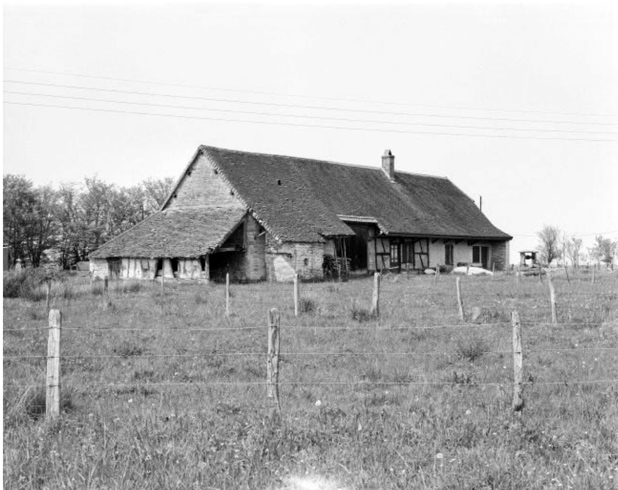
Ferme : vue générale.
