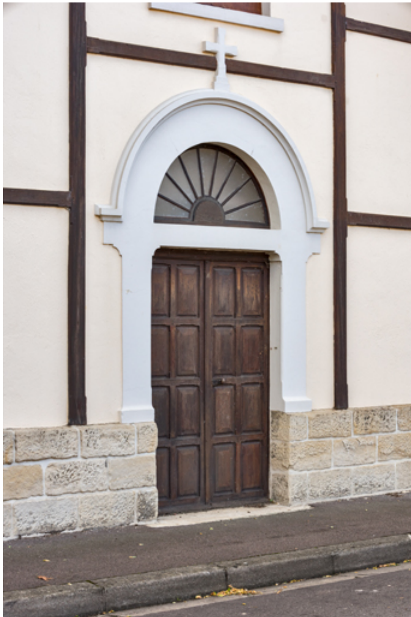
Porte de la façade antérieure.
