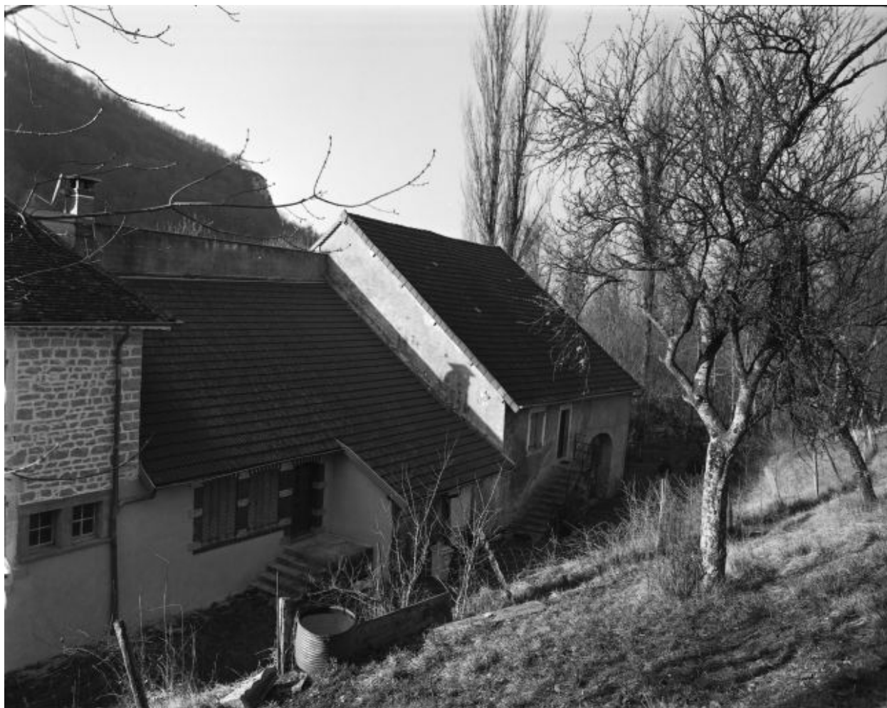
Aile nord.Logement et ferme.
