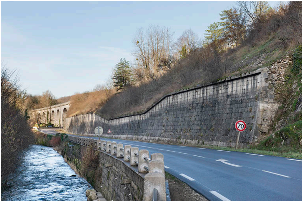
Viaduc et mur de soutènement, depuis l'est.
