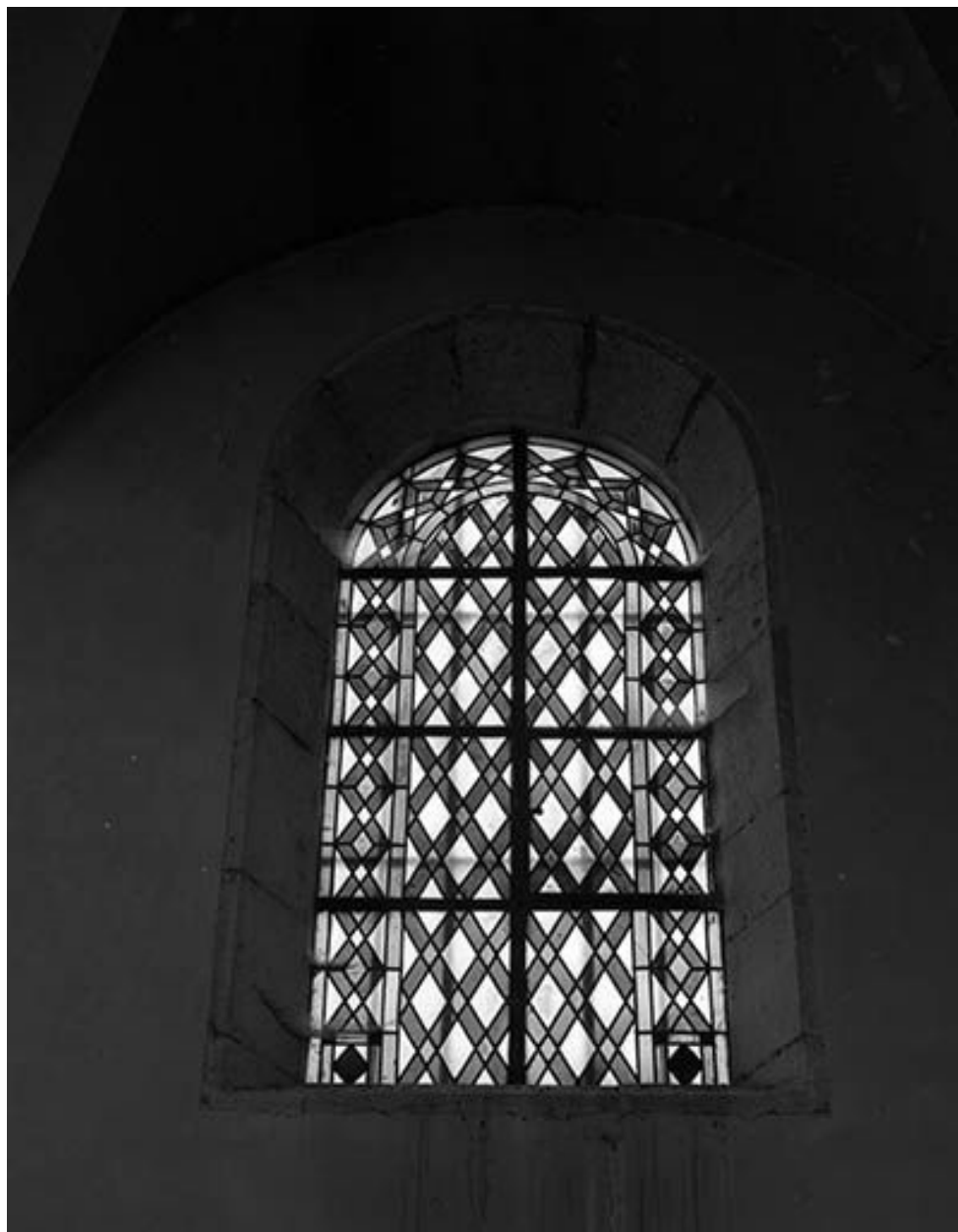
Vue générale de la baie n° 101.
