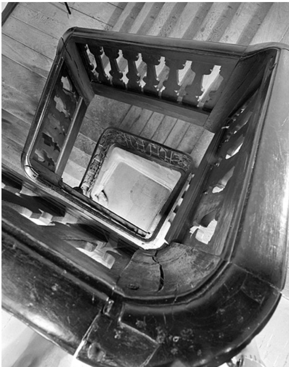
Escalier vu du deuxième étage.
