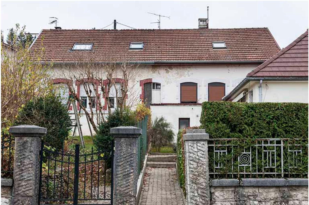
Atelier de fabrication : façade antérieure.
