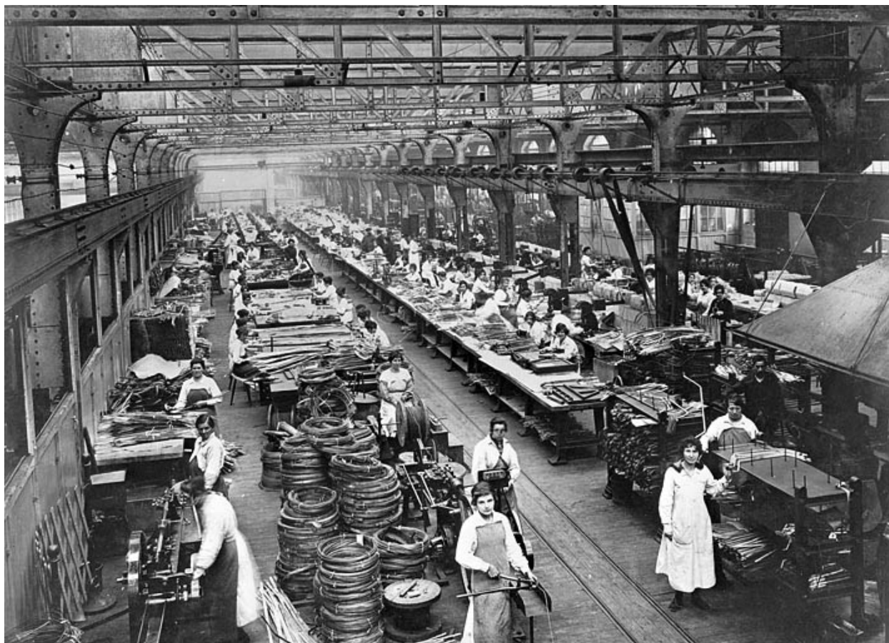
Bobinage dans l'atelier des grandes dynamos.
