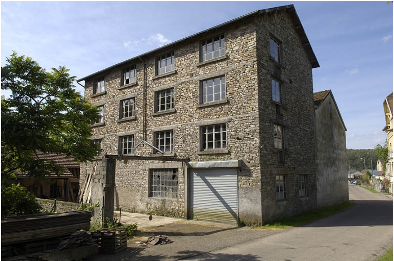
Extension orientale de l'atelier de fabrication.
