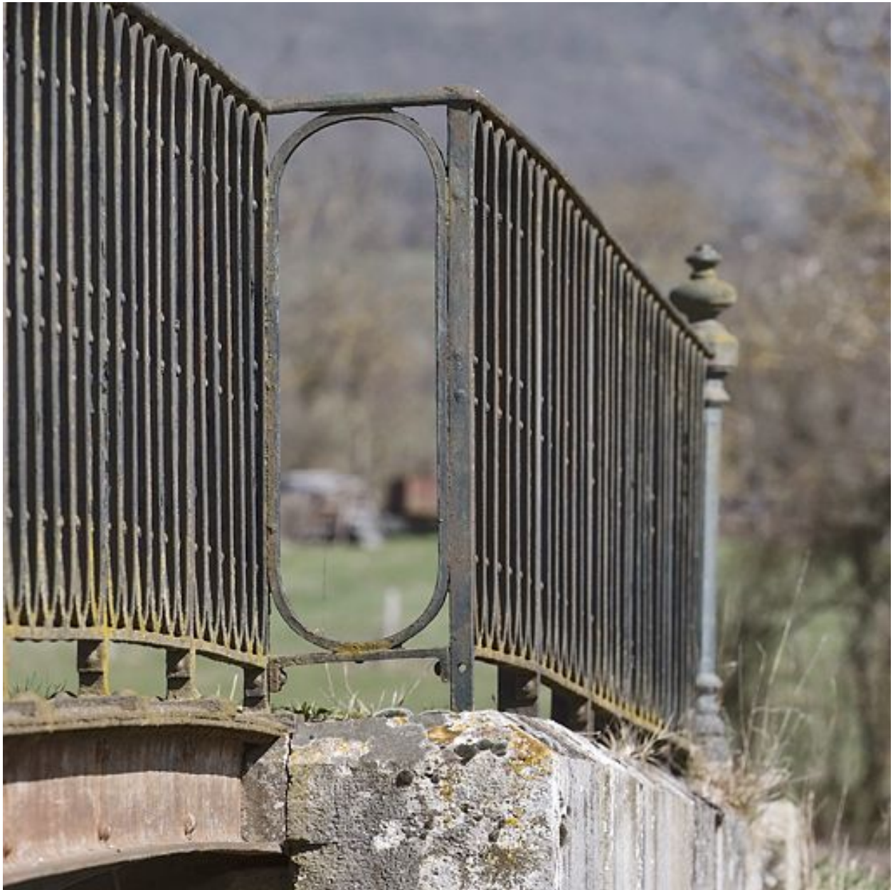
Le pont routier, détail des garde-corps.
