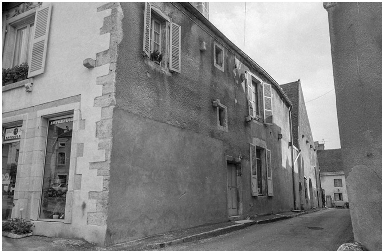
Façades antérieure et latérale droite.
