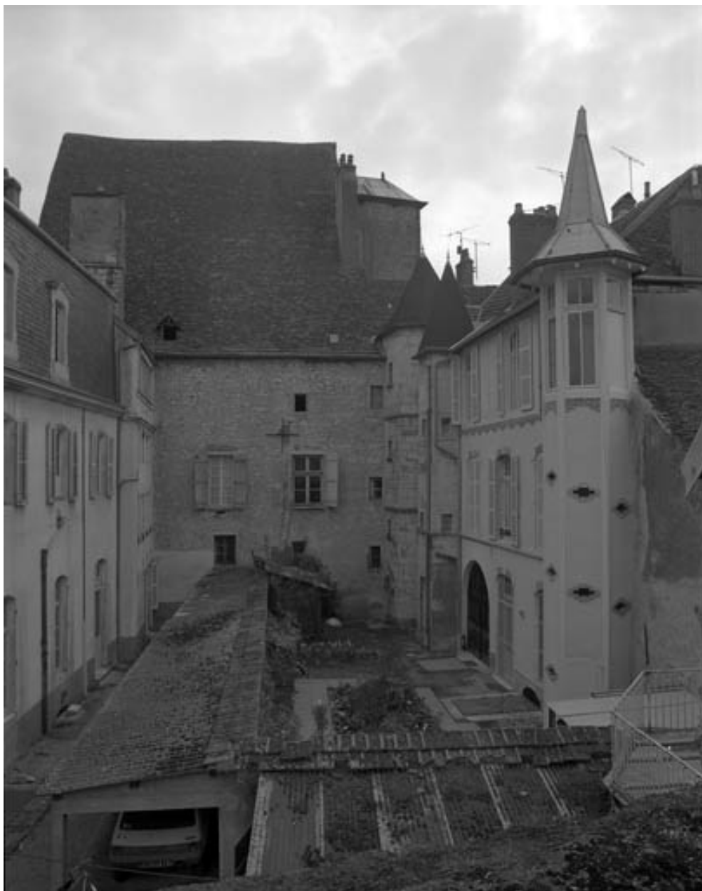
Façade latérale gauche : vue éloignée.
