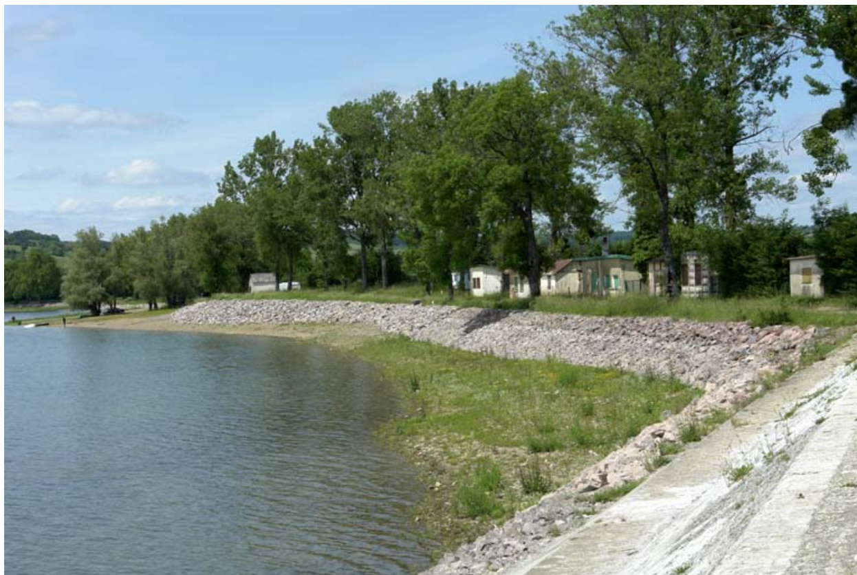
Digue est, extrémité nord.
