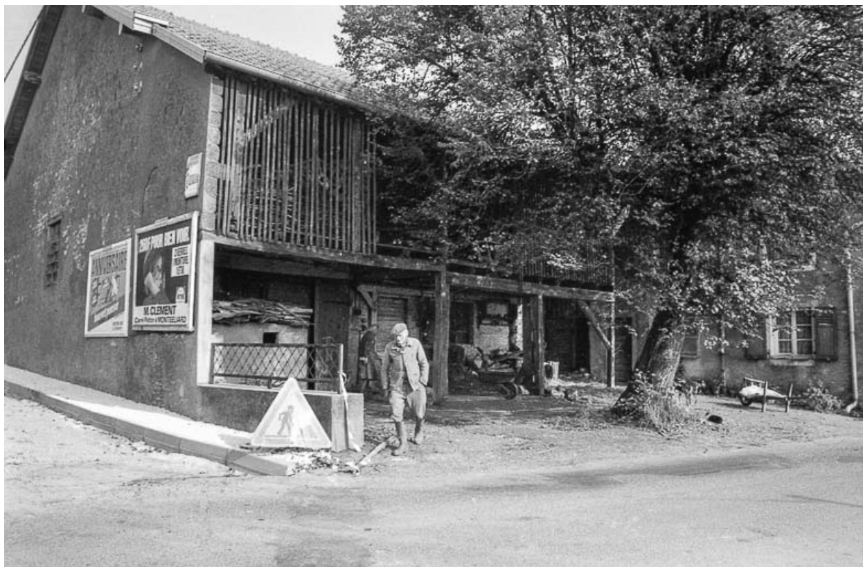
Façade antérieure : détail.
