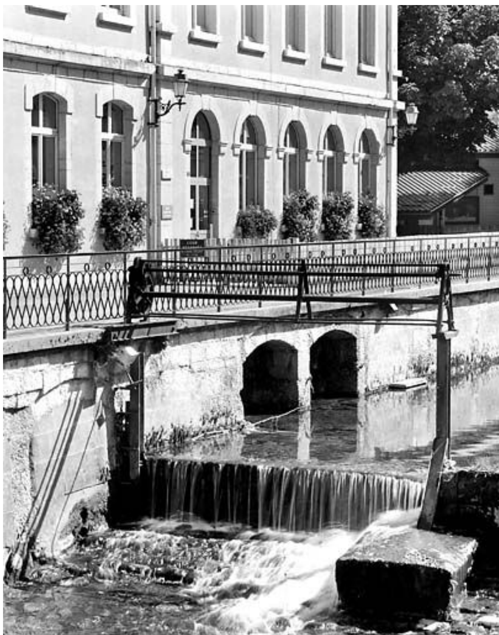
Barrage et prise d'eau de l'ancien site Paul Odobey Fils (1 à 13 cours Paul Odobey). Le canal d'amenée passe sous la mairie.
