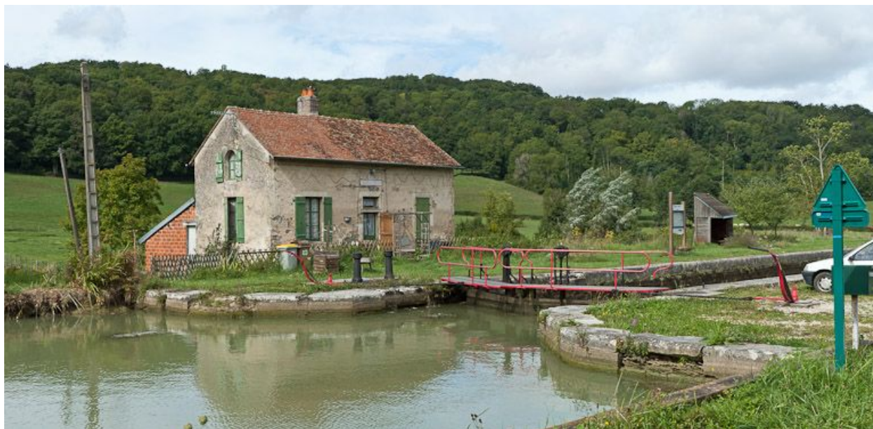
Vue du site d'écluse depuis l'amont.
