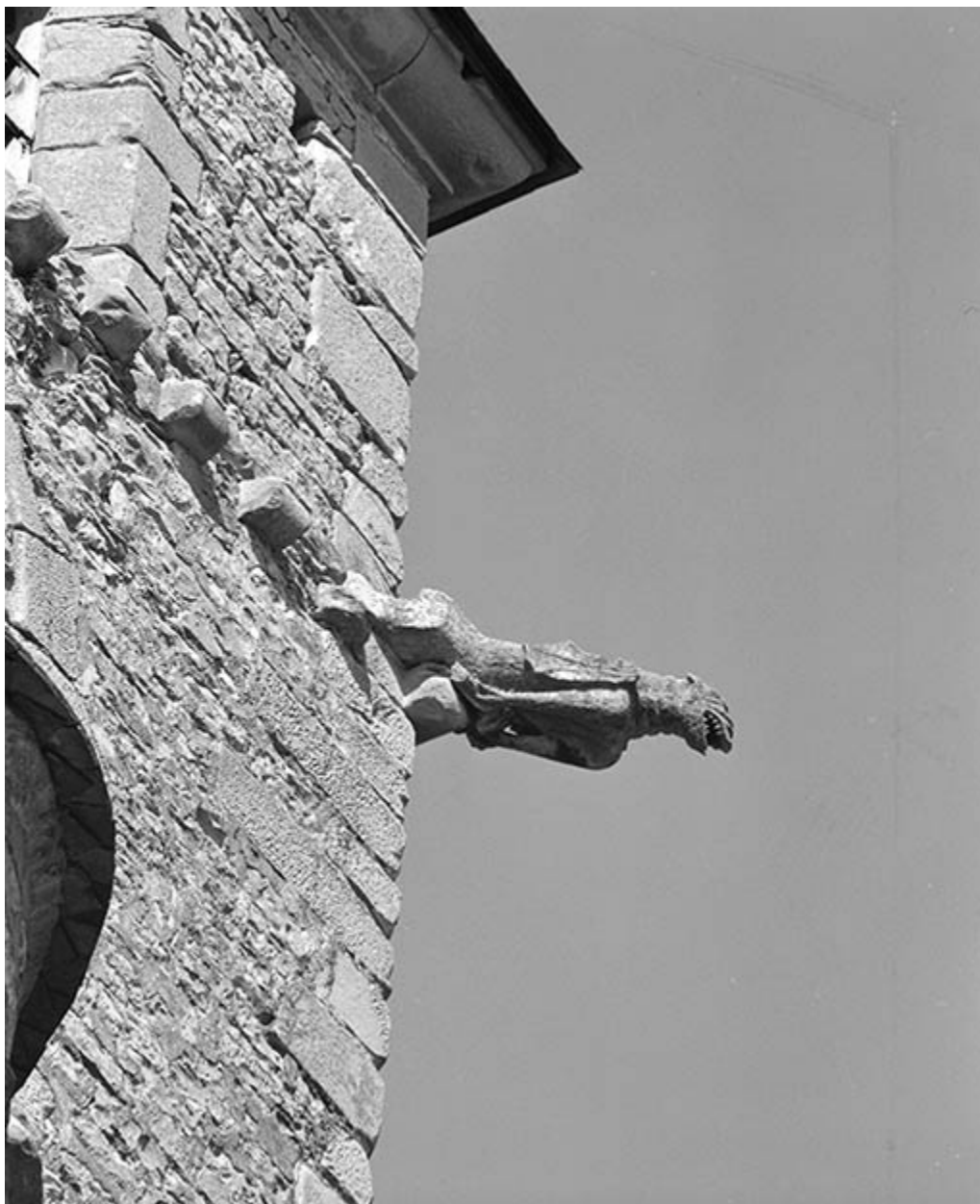
Façade droite du choeur, détail : gargouille droite.
