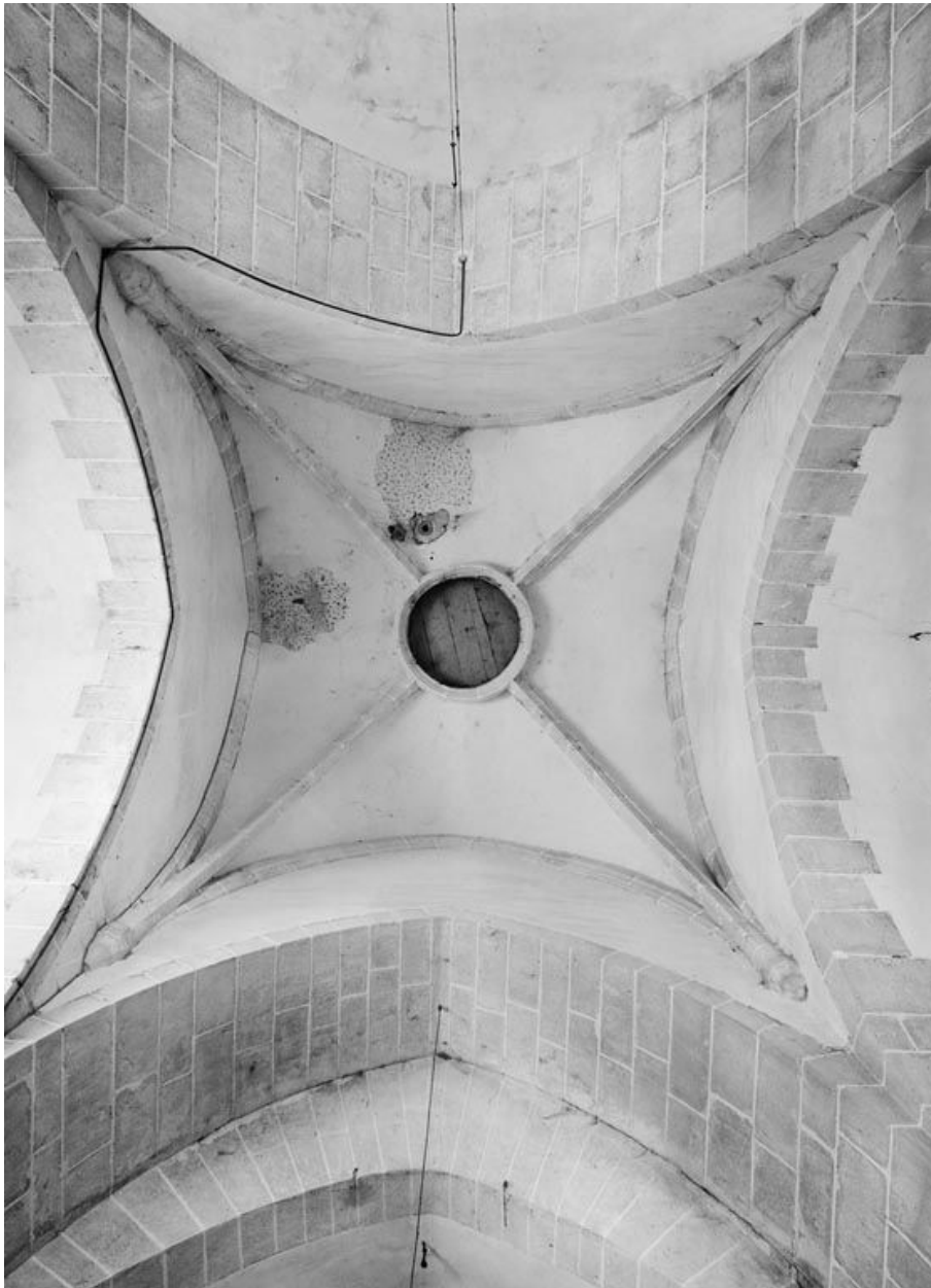
La voûte de la travée sous clocher.
