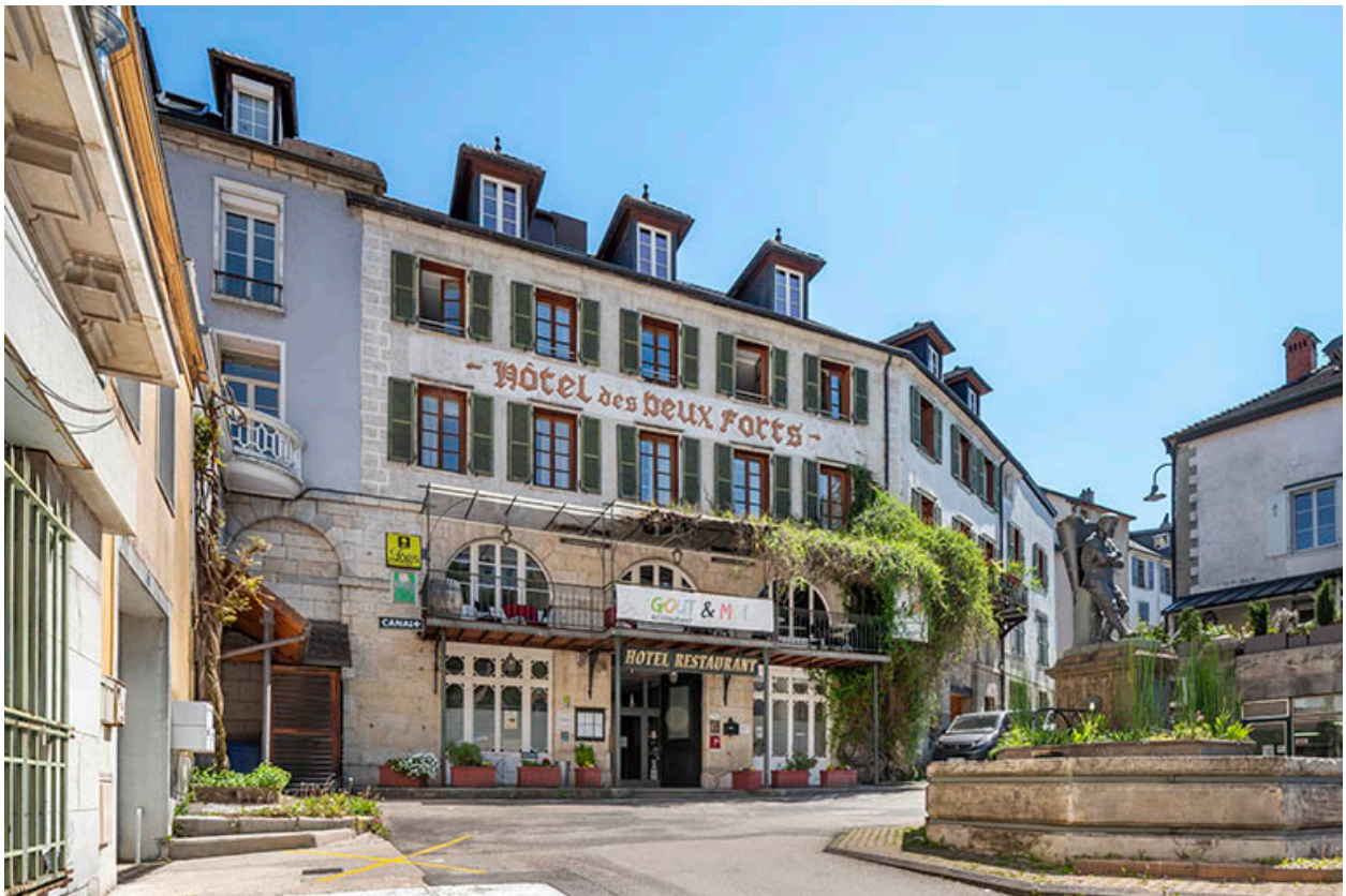
Façade sur la place du Vigneron, vue de trois quarts.
