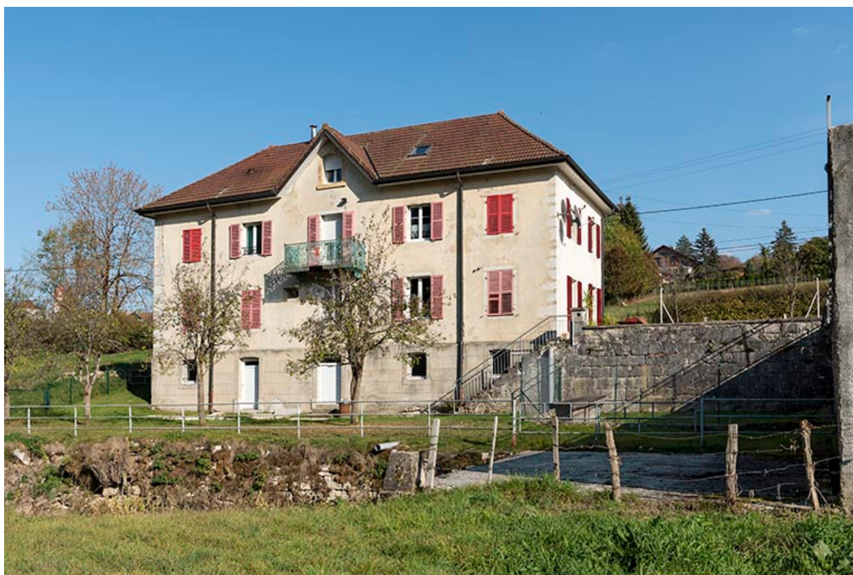
Maison : façade postérieure.
