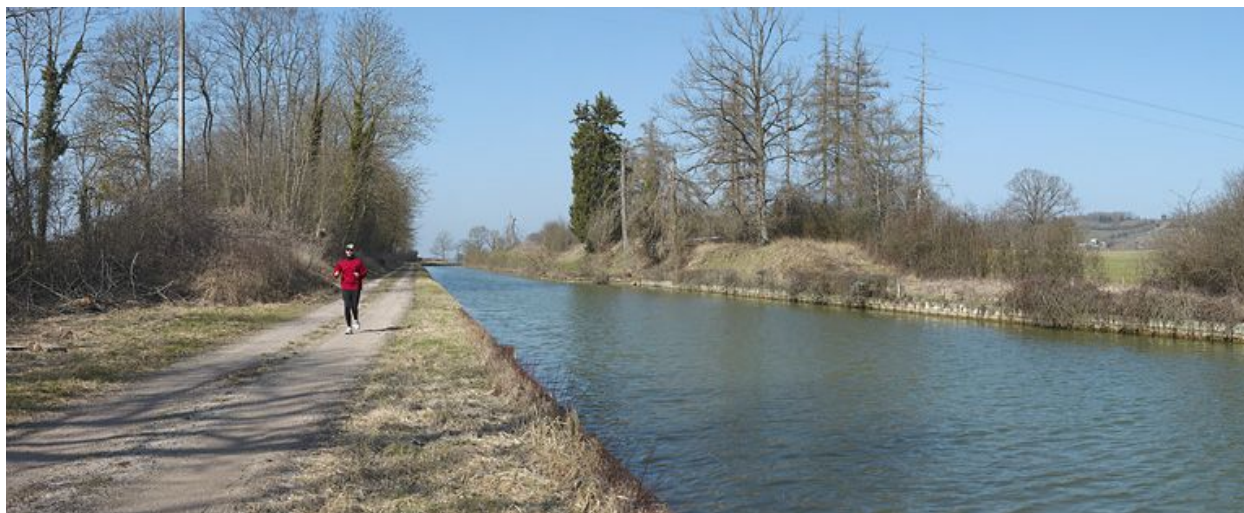
Entrée de la tranchée.
