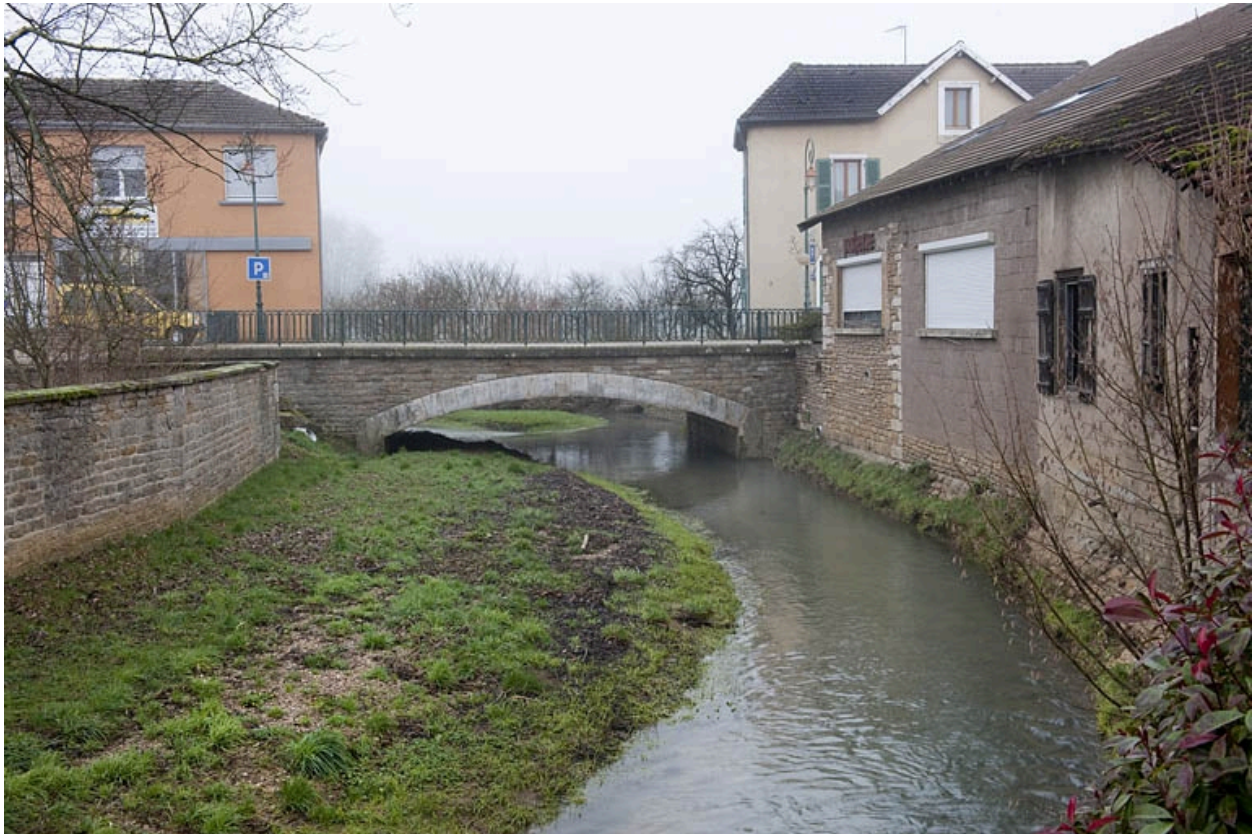
Pont sur le Drigeon, avenue de la Gare.
